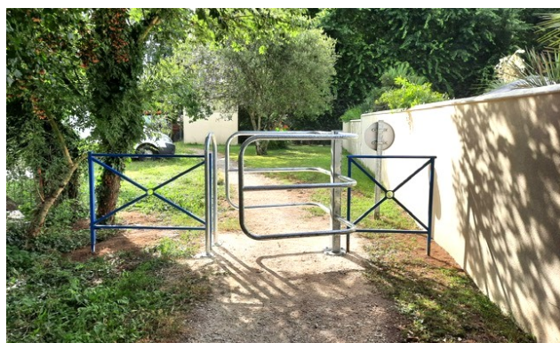
Équipement des chemins avec des barrières sélectives au city-stade
